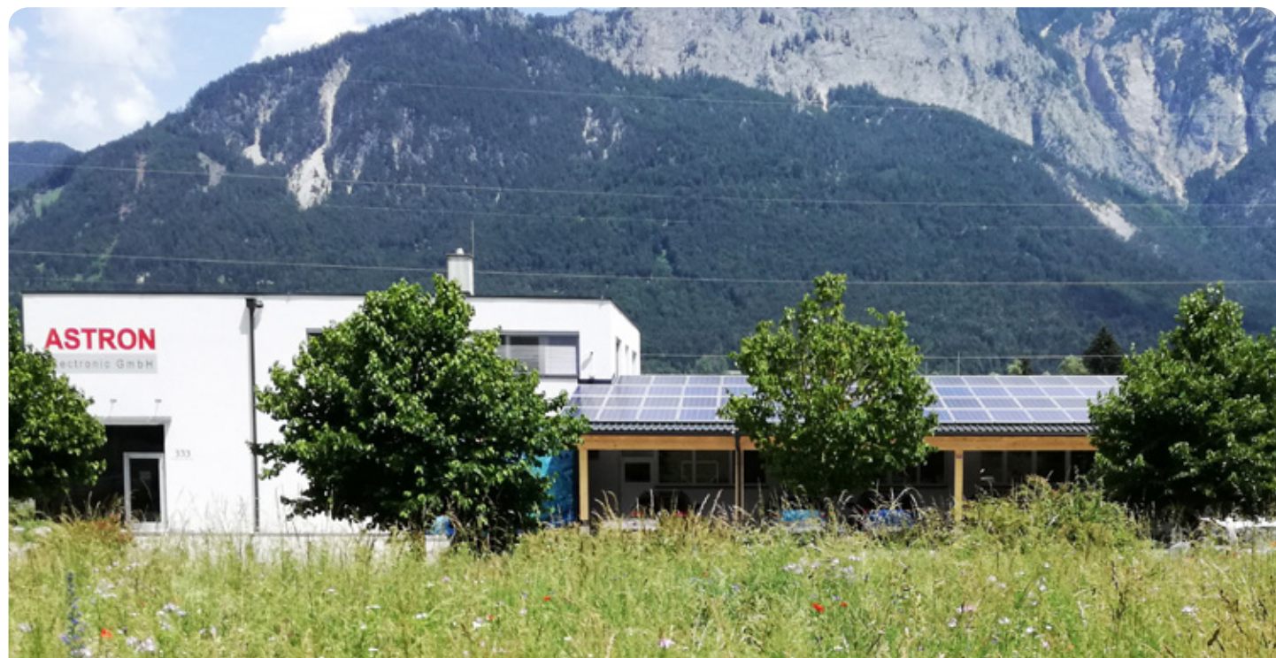
Die neue Holzkonstruktion mit den Photovoltaikmodulen.
