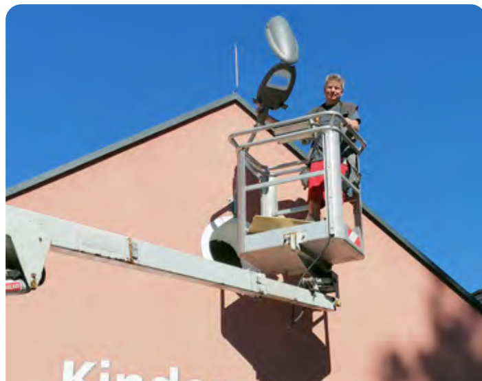
Stufe 2 der Straßenbeleuchtungsumstellung auf LED durch die Fa. Elektro J. Amenitsch GmbH
