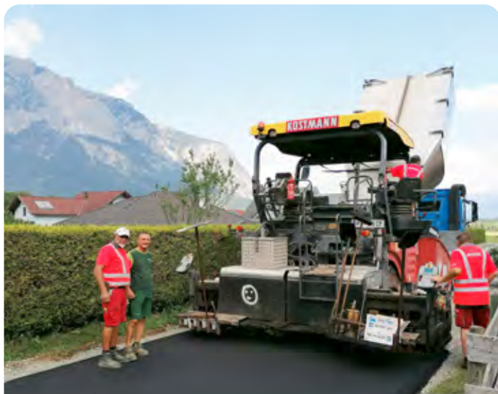
Asphaltierungsarbeiten in der Siedlungsstraße Feistritz-Ost mit Ausschussobmann GR Markus Melchior und der bauausführenden Firma Kostmann GesmbH
