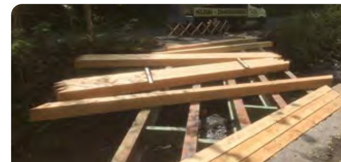
Neuerrichtung Lärchenholzbrücke im Feistritzgraben
