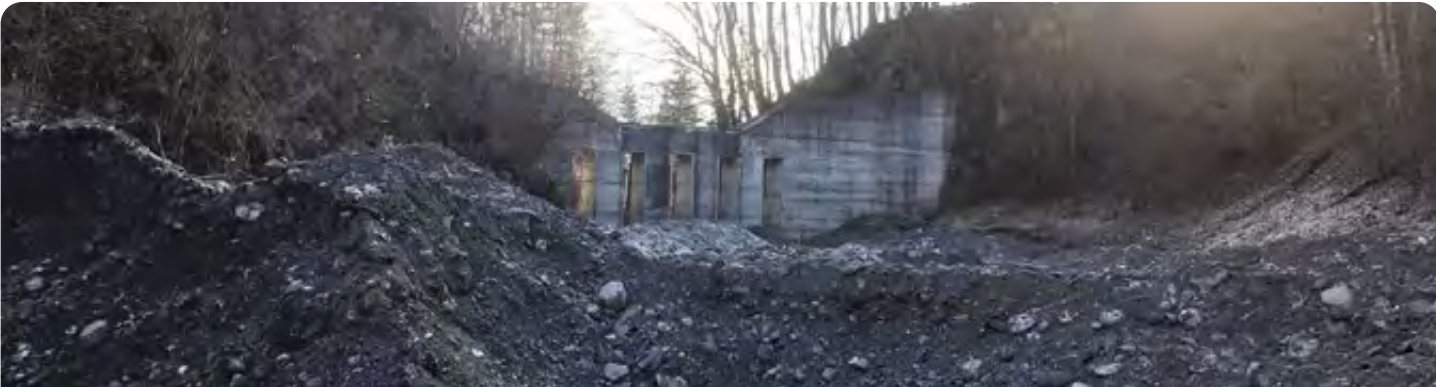
Schotterentnahme bei der Dosiersperre
